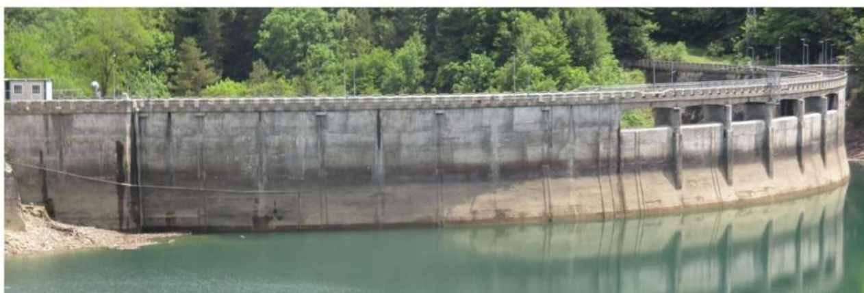
Foto 2 – Paramento di monte della diga da mantenere
