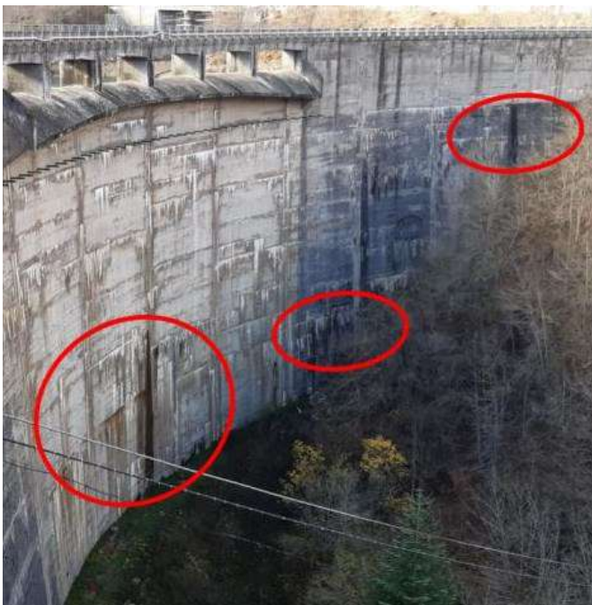
Foto 6,7 – Paramento di valle, con evidenziati: (a sinistra) permeazioni ed incrostazioni, da pulire con idroscarifica, (a destra) distacchi localizzati del calcestruzzo dalla spalla destra con arbusti attecchiti.
