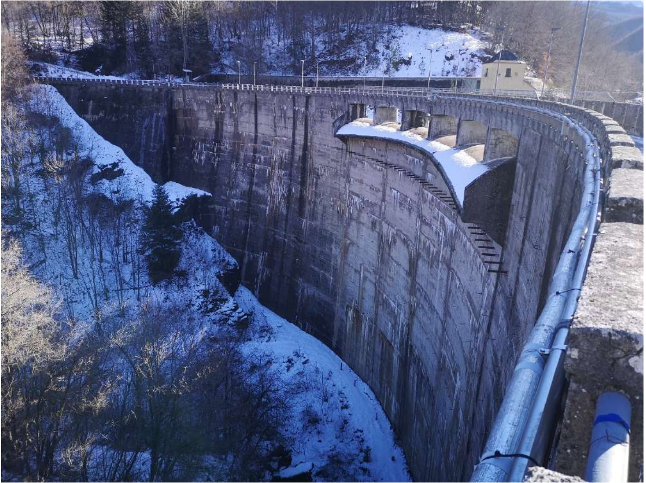
Foto 5 – Paramento di valle
