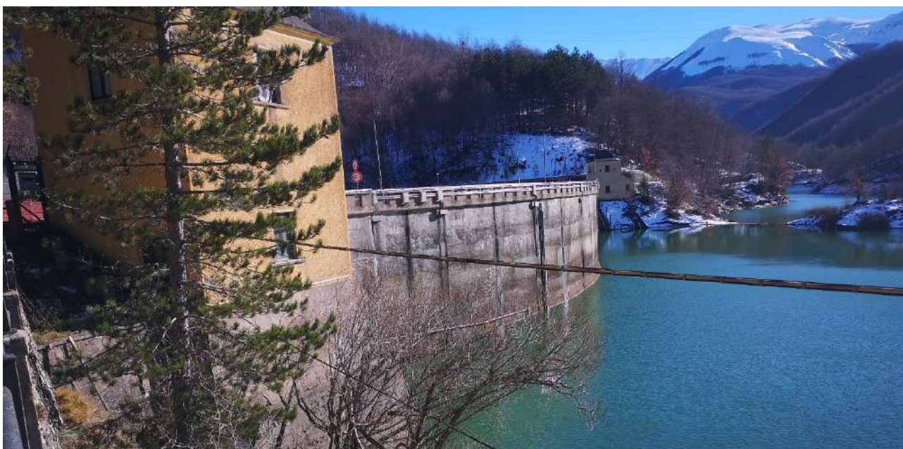
Foto 1 – Diga Provvidenza, paramento di monte
