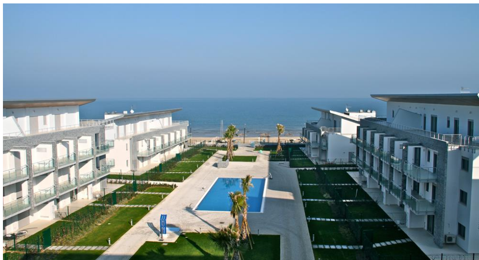
Complesso residenziale Le Dune – Lotto A
