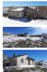
rilievi fotografici stato di fatto
