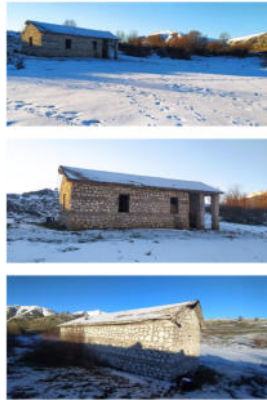
rilievi fotografici stato di fatto
