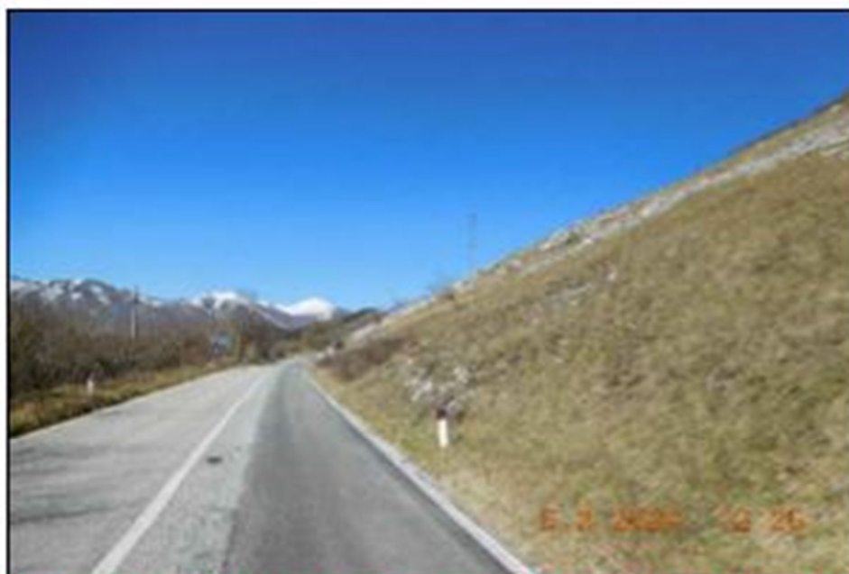
FOTO N. 1 TRAL. ESISTENTE, LINEA MT IN CONDUTTORI NUDI
