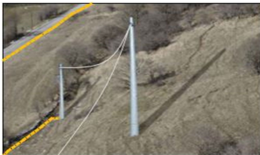
FOTO N. 3/BIS RICOSTRUZ. LINEA MT IN CAVO AEREO, POSA IN OPERA DI NUOVI SOSTEGNI, PALO CAPOL, PER CAVO INTERR.
