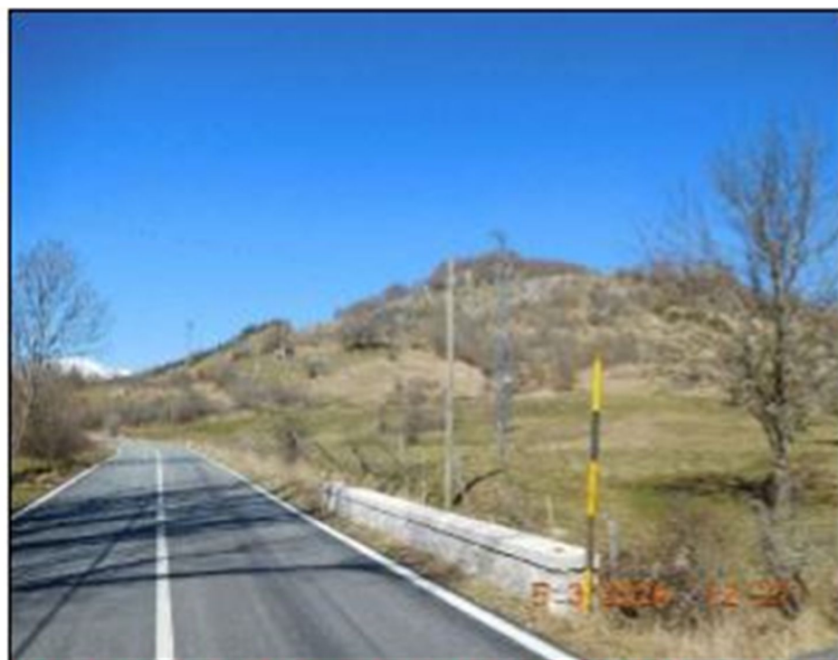
FOTO N. 4 TRAL. ESISTENTE, LINEA MT IN CONDUTTORI NUDI
