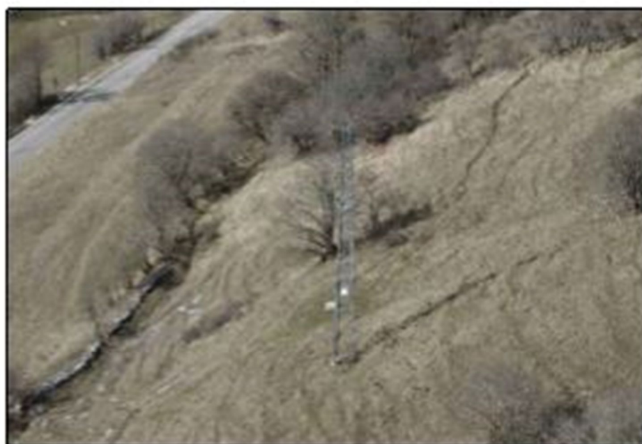
FOTO N. 3 TRAL. ESISTENTE, LINEA MT IN CONDUTTORI NUDI
