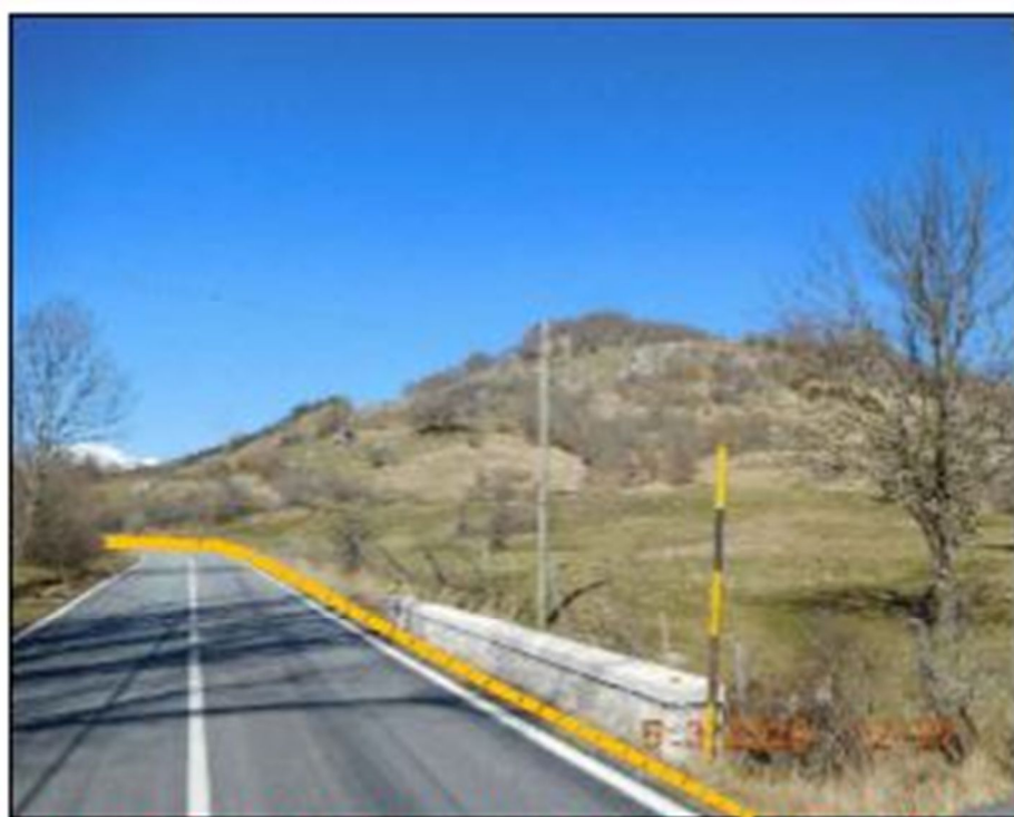
FOTO N. 4/BIS DEMOLIZ. LINEA AEREA, POSA DI CAVO INTERR.
