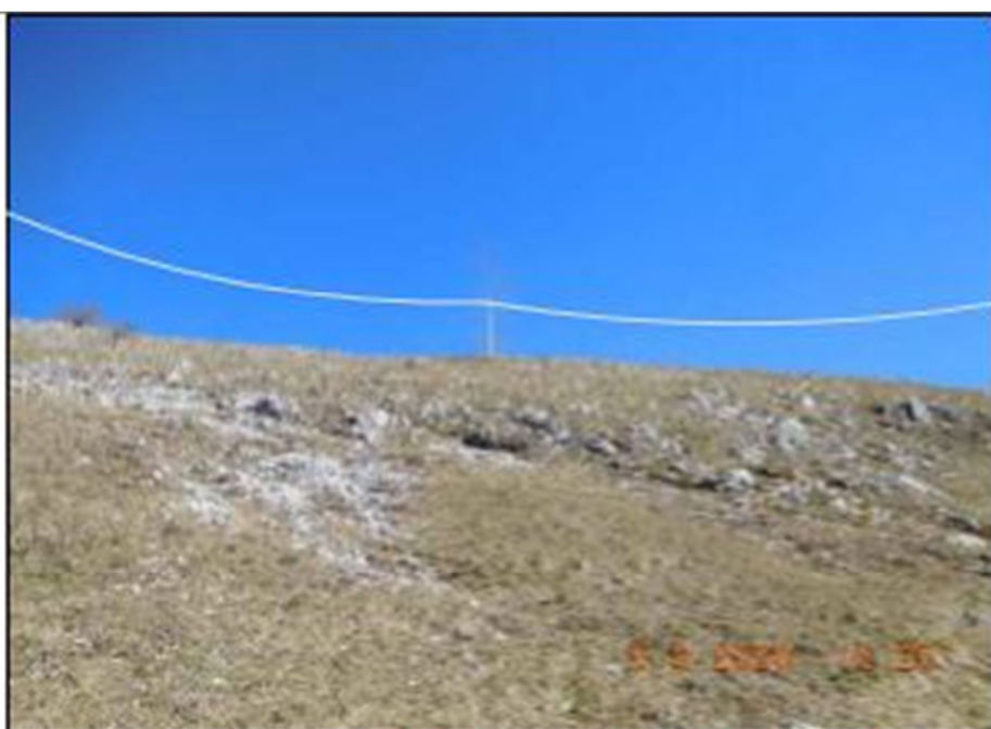
FOTO N. 2/BIS RICOSTRUZIONE LINEA MT CON POSA DI NUOVO SOSTEGNO E CAVO AEREO
