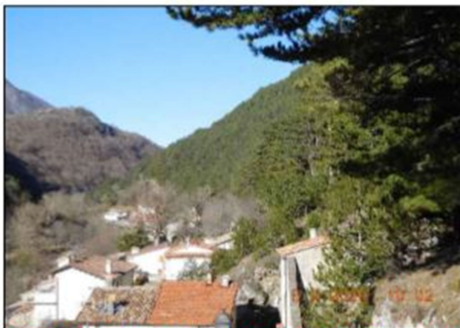
FOTO N. 2/BIS LINEA MT IN TRALICCI SMANTELLATA SOSTITUITA DA CAVO INTERRATO
