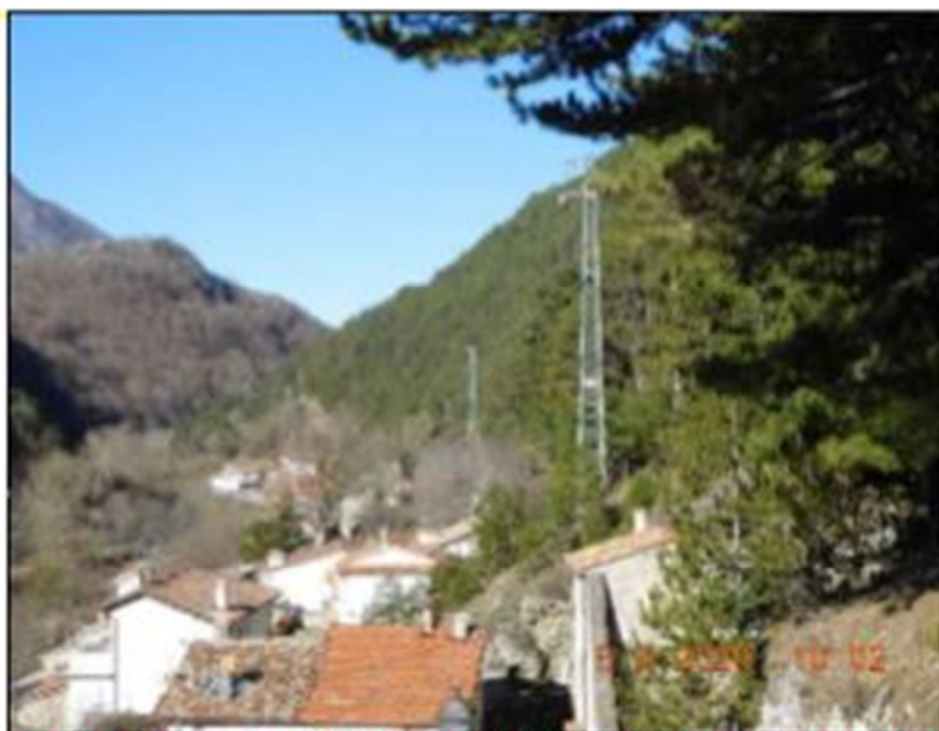
FOTO N. 2 LINEA MT AEREA ESISTENTE COMPOSTA DA: TRALICCI E CONDUTTORI NUDI
