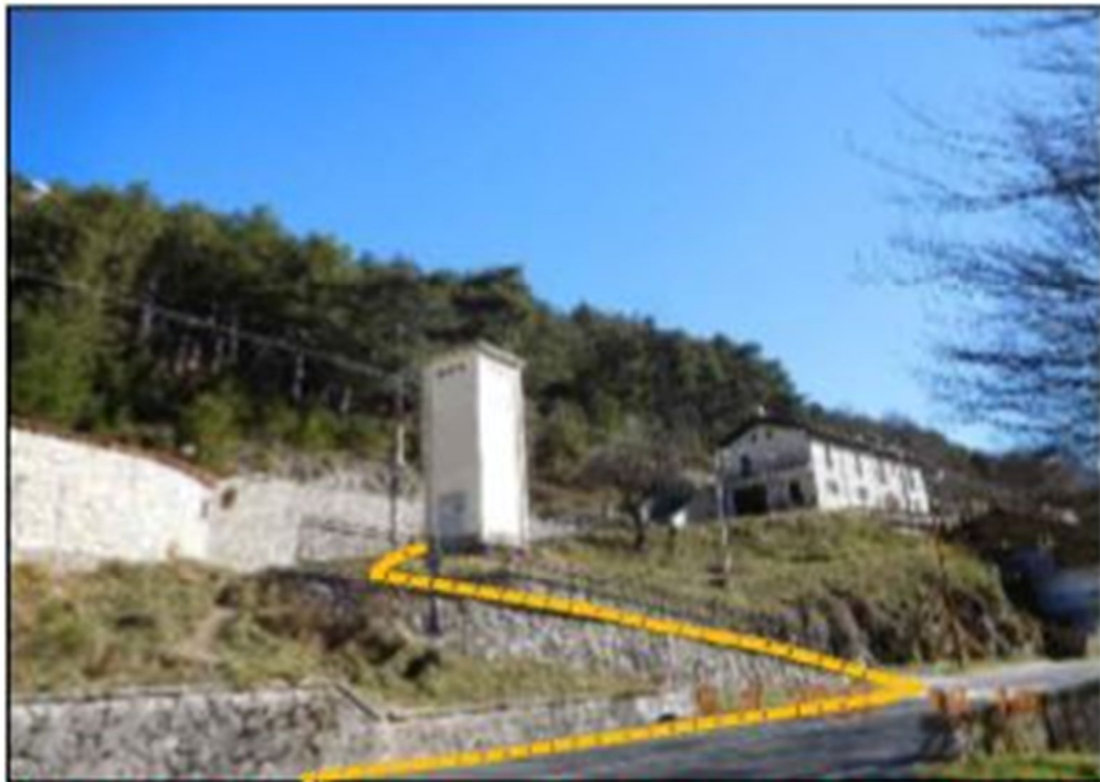
FOTO N. 4/BIS CABINA REGINA SITUAZIONE POST OPERAM
