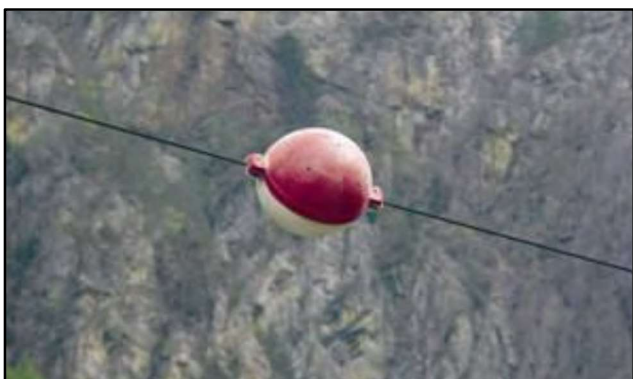
Immagine 2- Dispositivi di dissuasione visiva nelle linee di alta tensione (AT): sfera di poliuretano e spirale
