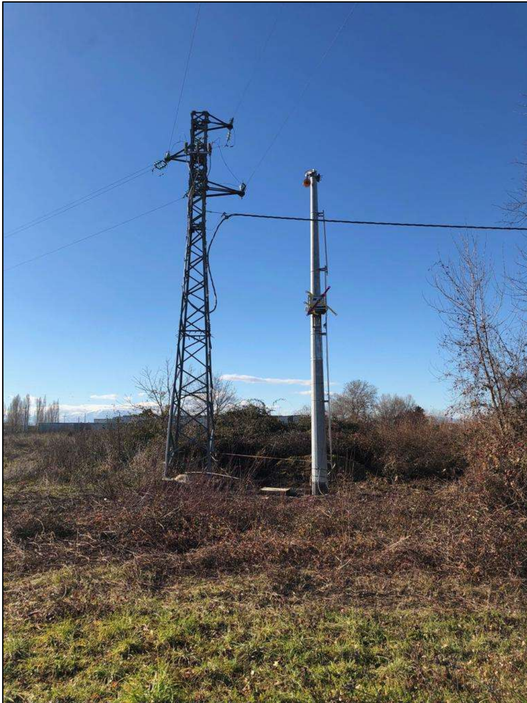
Immagine 3 – passaggio da un elettrodotto vecchio a cavi nudi in rame ad uno nuovo Elicord
