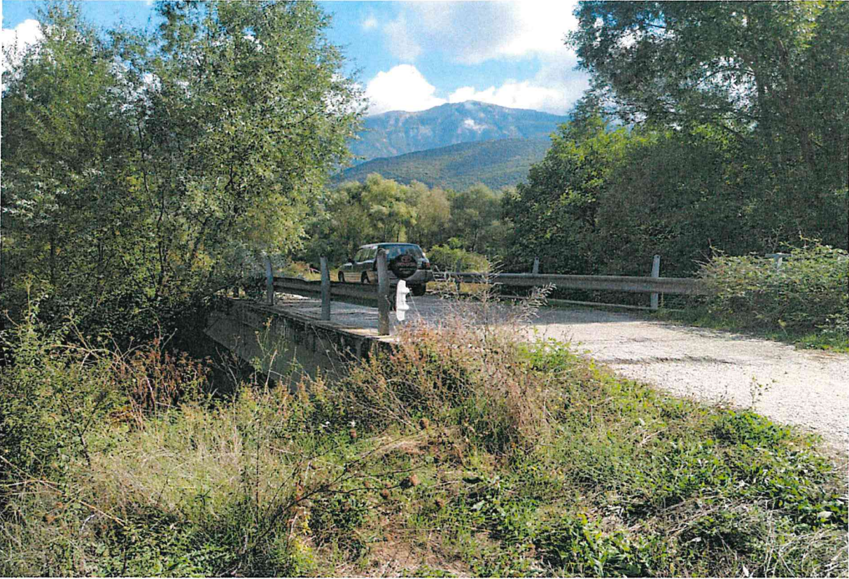
foto 3 vista dell'area del ponte
