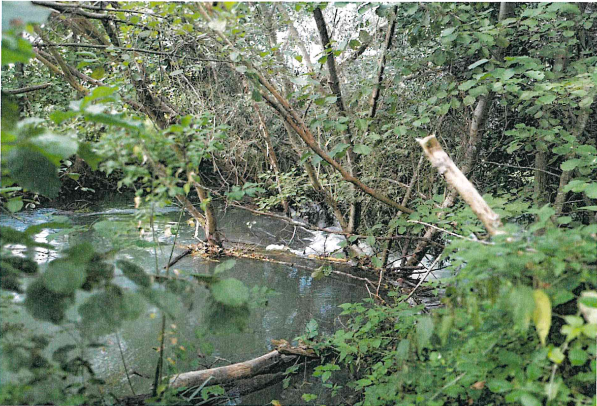
foto 1 vista del fiume e dell'ostruzione lato monte
