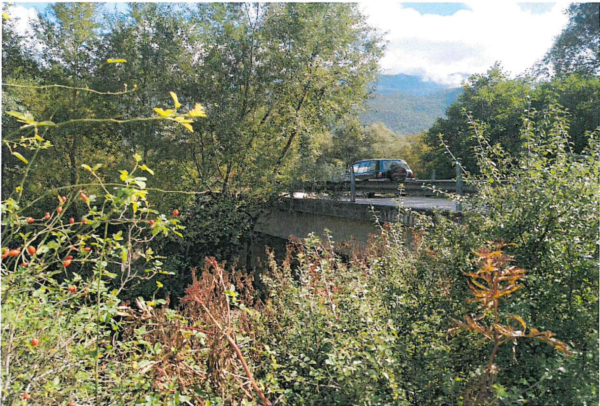
foto 4 vista dell'area del ponte
