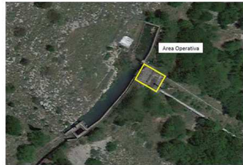
Figura 8 - Area Operativa – Edificio VF Testa Condotta
