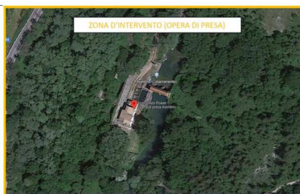
Figura 4 - Zona di intervento - Opera di presa
