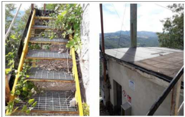
Figura 5 - Edificio VF testa condotta
