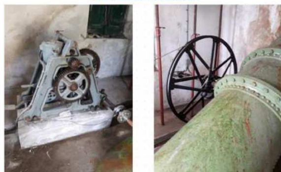
Figura 6 - Valvola a farfalla da sostituire
