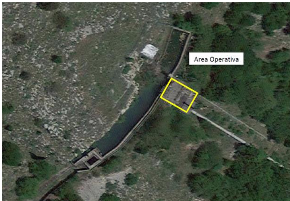
Figura 8 - Area Operativa – Edificio VF Testa Condotta
