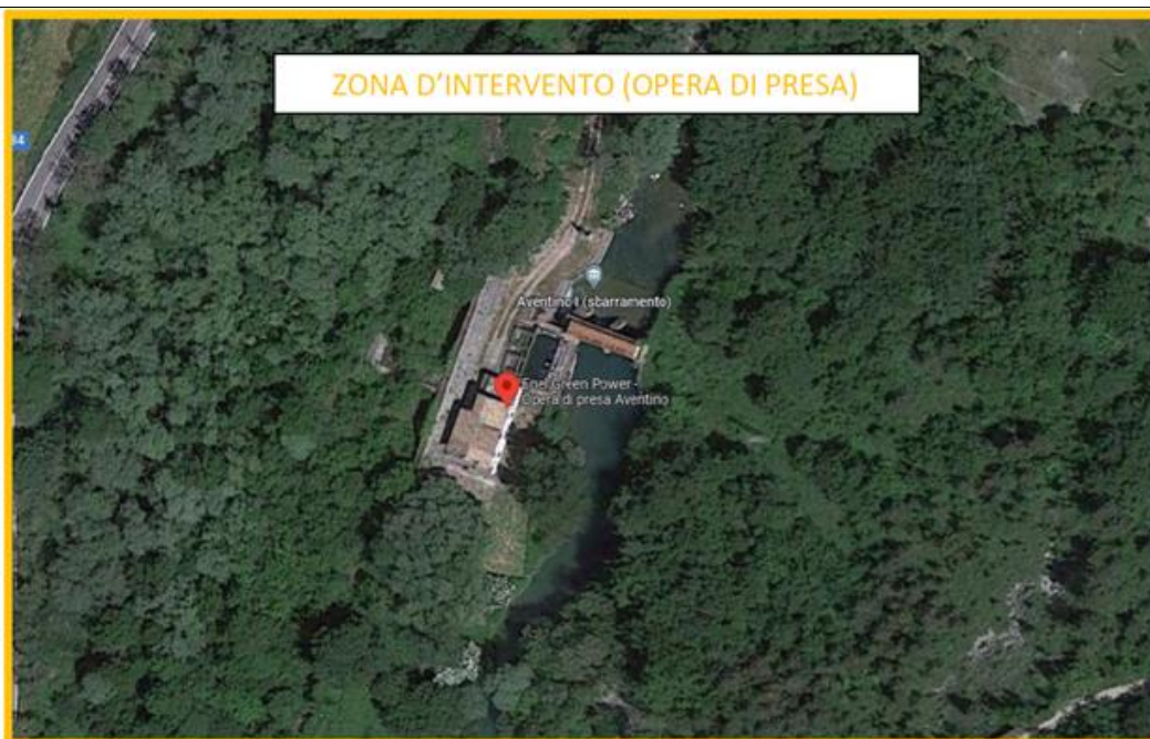
Figura 4 - Zona di intervento - Opera di presa
