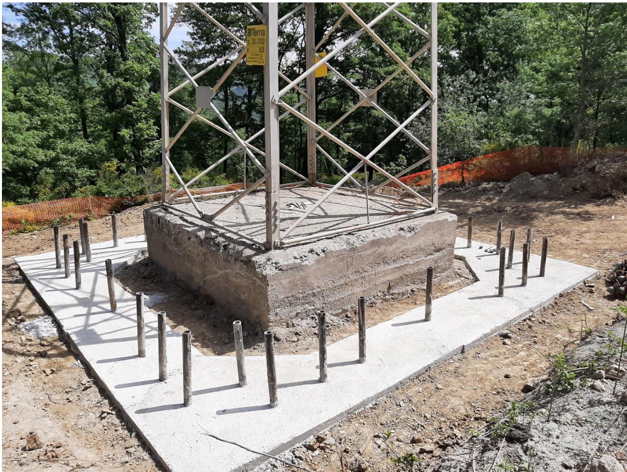
Figura 1 - esempio di fondazione su micropali
