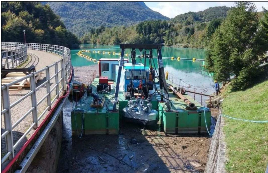
*Figura 5-2: Esempio di applicazione di un sistema di dragaggio a bacino pieno in un invaso idroelettrico*
