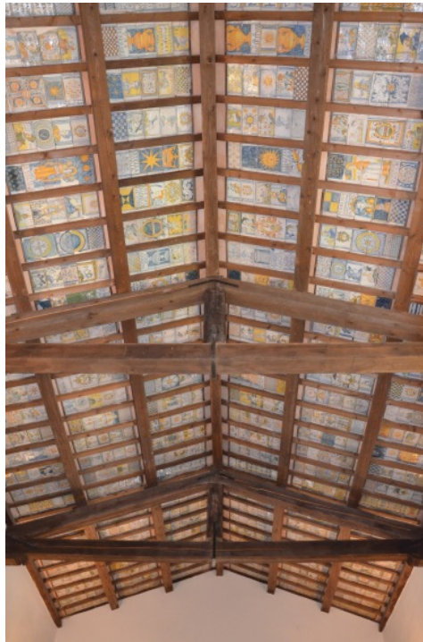
Fig. n.7 volta della chiesa di S. Donato
