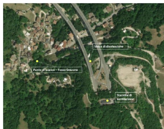
Figura 6-2 Locali Tecnici Casale San Nicola. Vasca di disoleazione e punto di scarico delle acque trattate dei LNGS
