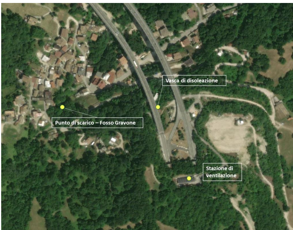
Figura 6-2 Locali Tecnici Casale San Nicola. Vasca di disoleazione e punto di scarico delle acque trattate dei LNGS
