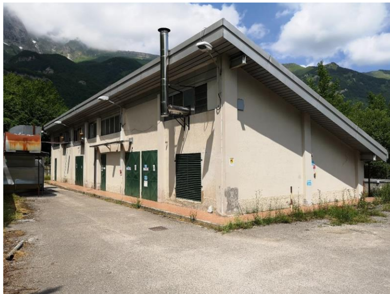
Figura 4-5 Cabina elettrica di casale San Nicola
