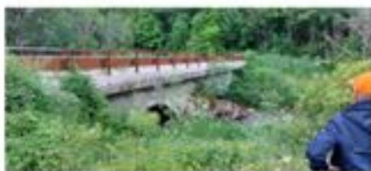
Foto 4-6-8 Comune di Acciano - Ponte San. Nicola - stato dei luoghi nel Giugno 2023
