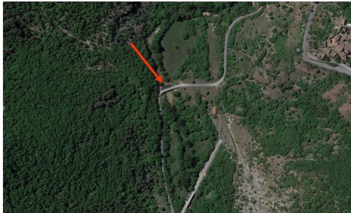
Fig. 3 - veduta aerea - ponte in loc. S. Antonio comune di Acciano
