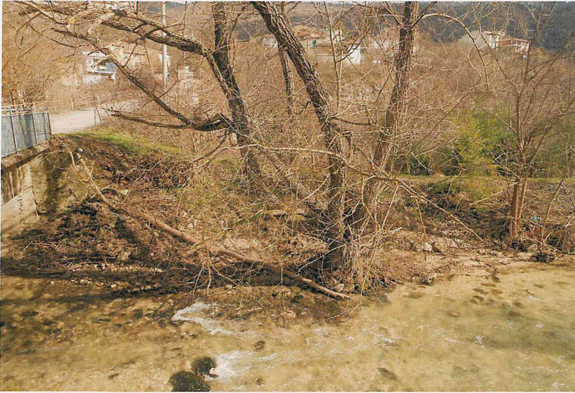
foto 5 vista del fiume in località Molina A. lato valle
