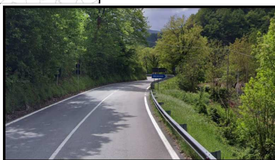
Foto n. 2 – punto di accesso alla frazione Vallocchio di Crognaleto dalla s.s. n. 80 km. 49,400
