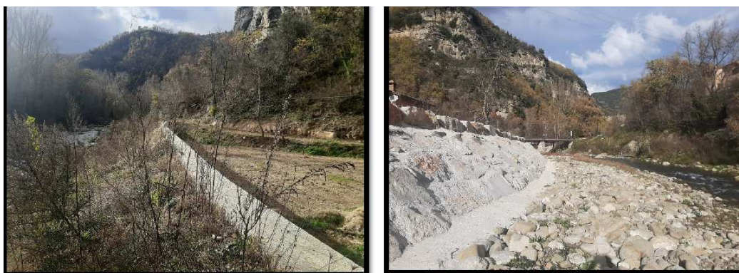
Foto n. 3 - 4: particolari del diaframma (in fase di rinaturalizzazione spontanea) e della scogliera in pietrame
