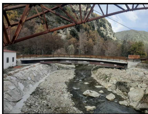
Foto n. 5: particolare del nuovo ponte
