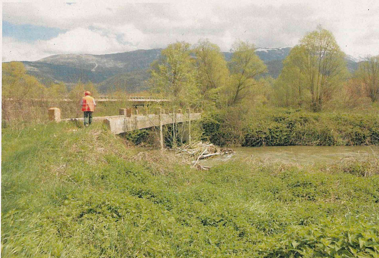
foto 10 vista del fiume loc. Ponticello
