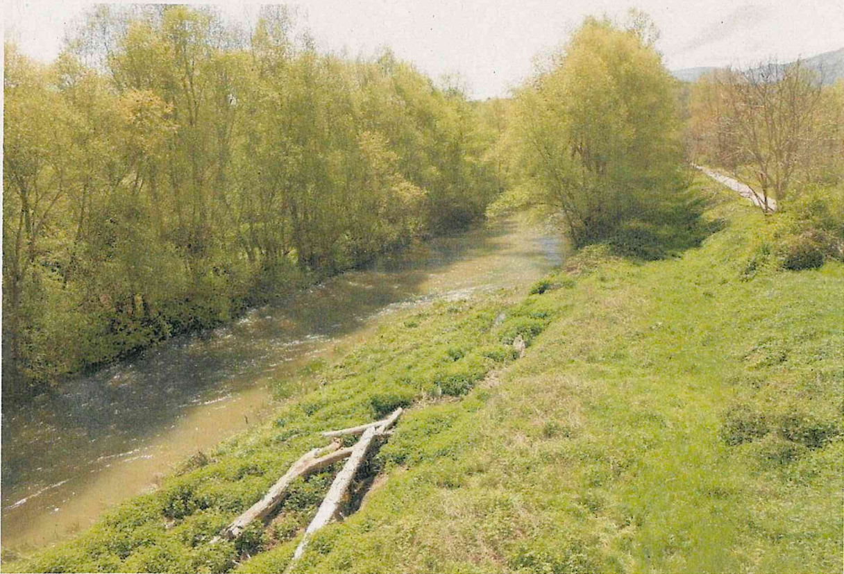
foto 4 vista dell'area loc. ponte via Colle Fonte lato monte
