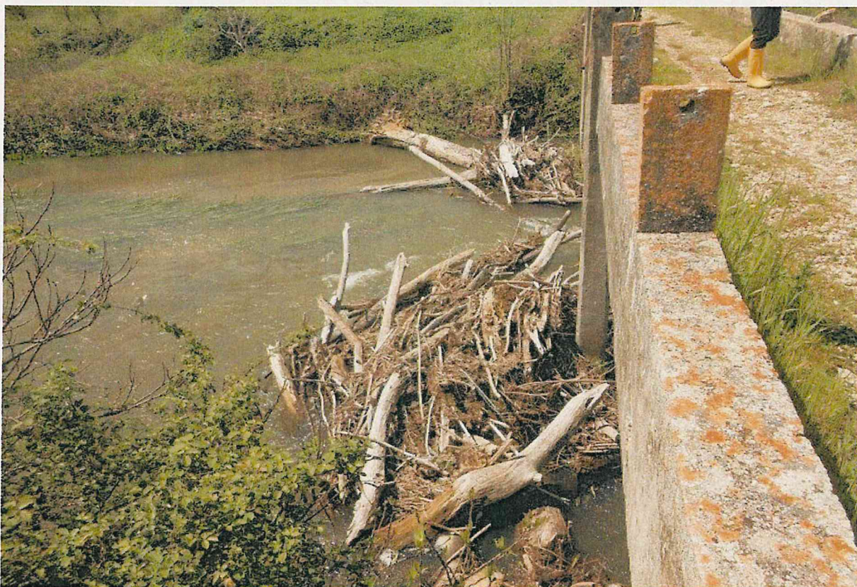
foto 9 vista del fiume loc. Ponticello
