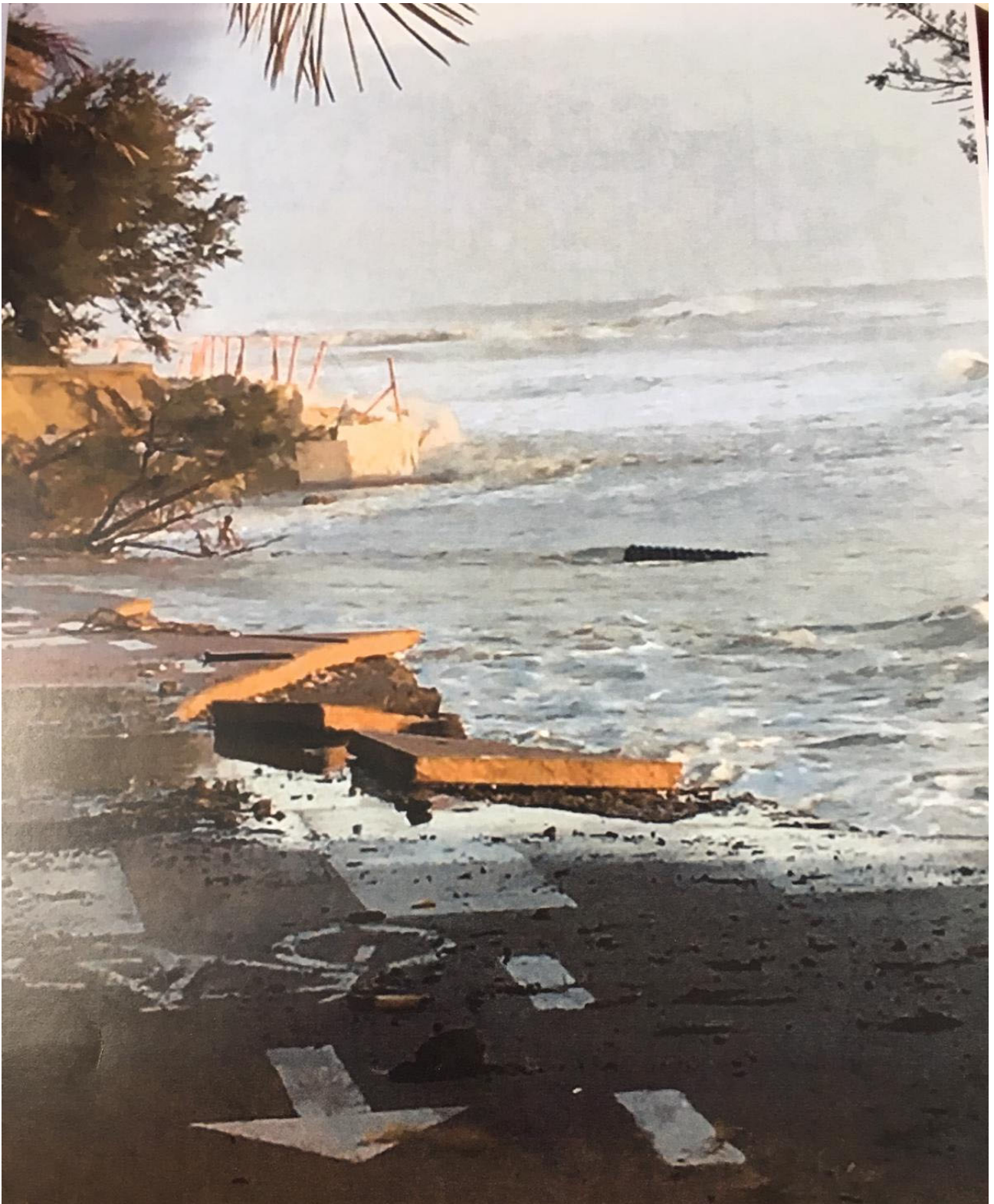
Fig. 2.3 Stato del litorale dopo le mareggiate del novembre 2019 – febbraio 2020
