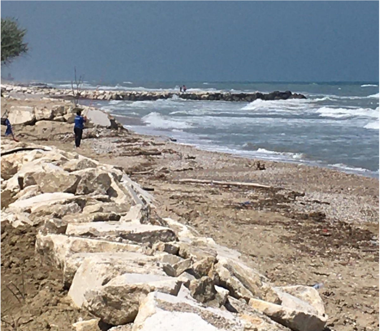
Fig. 2.2 Stato del litorale dopo le mareggiate del novembre 2019 – febbraio 2020
