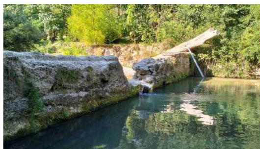
Rottura della briglia – foto scattata da valle
