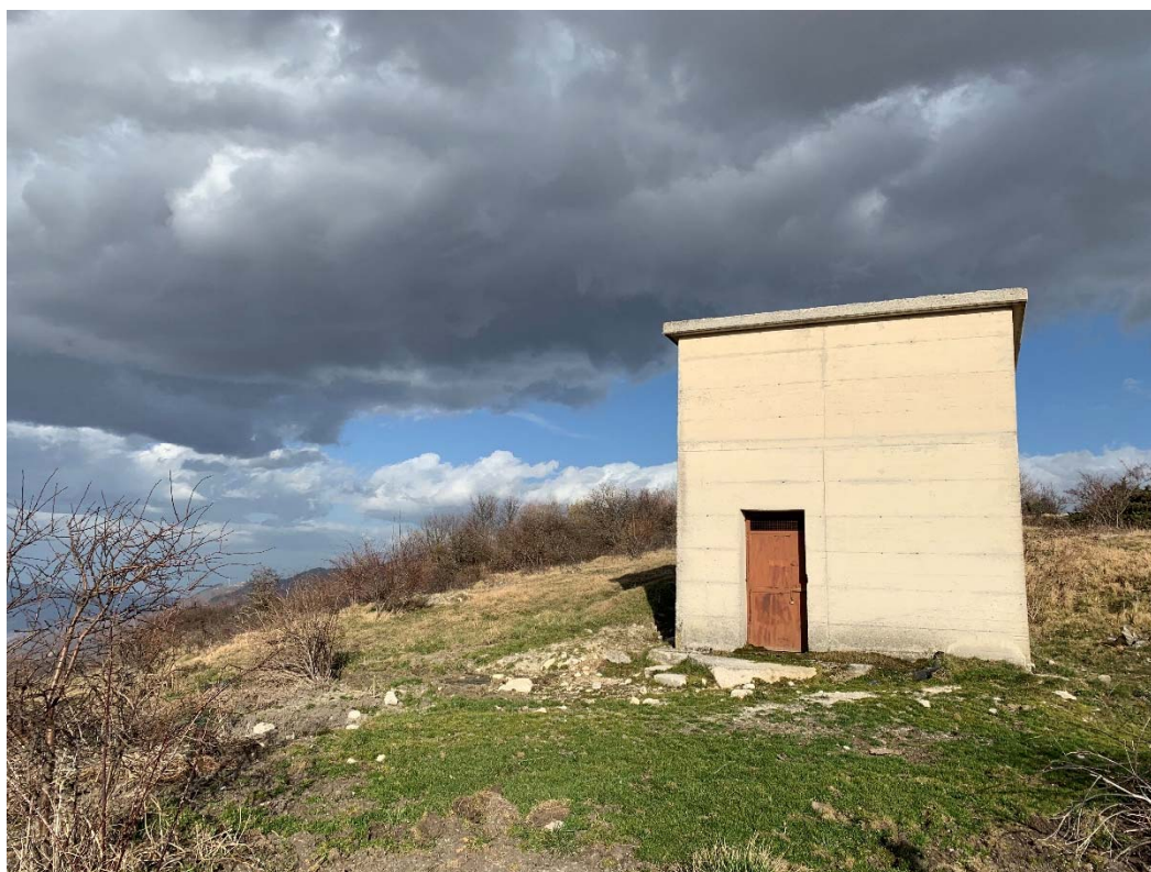
Serbatoio Colle Montagnola
