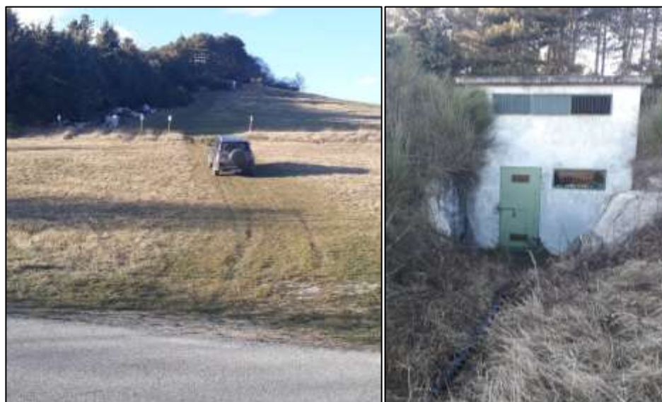
Figura -13 – A sinistra ingresso strada di campagna al Serbatoio di Borrello e nella foto a destra il serbatoio oggetto di intervento.
