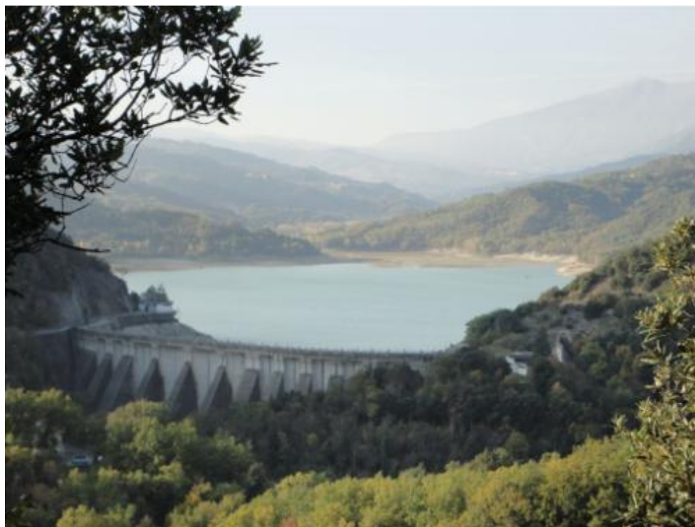
Figura 27: Diga di Sant'Angelo (Casoli).
