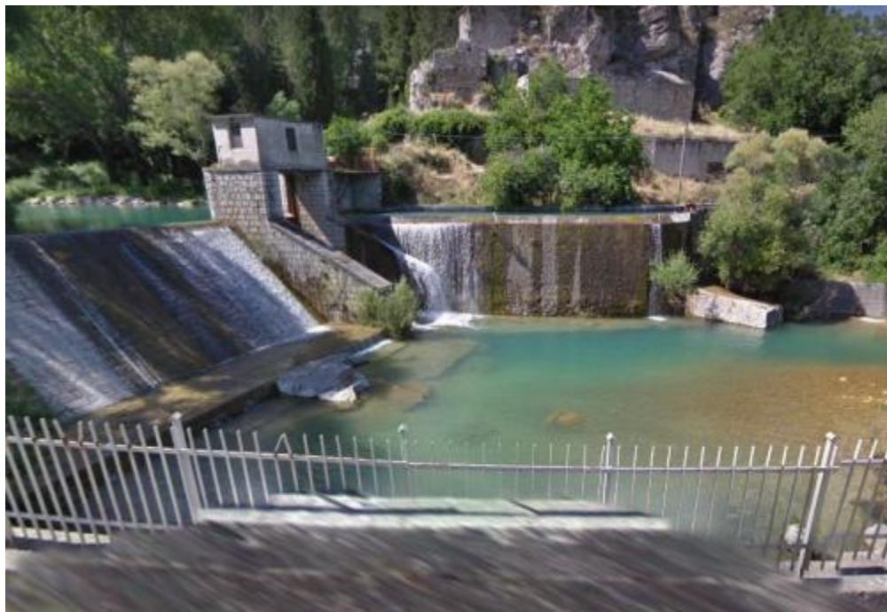
Figura 26: Briglia posta al termine verso monte del tratto proposto nel fiume Aventino
