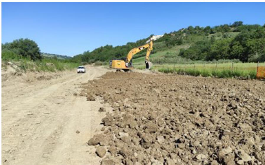
Figura 2-3 - Preparazione dello strato di contatto terreno-humus (riprofilatura)
