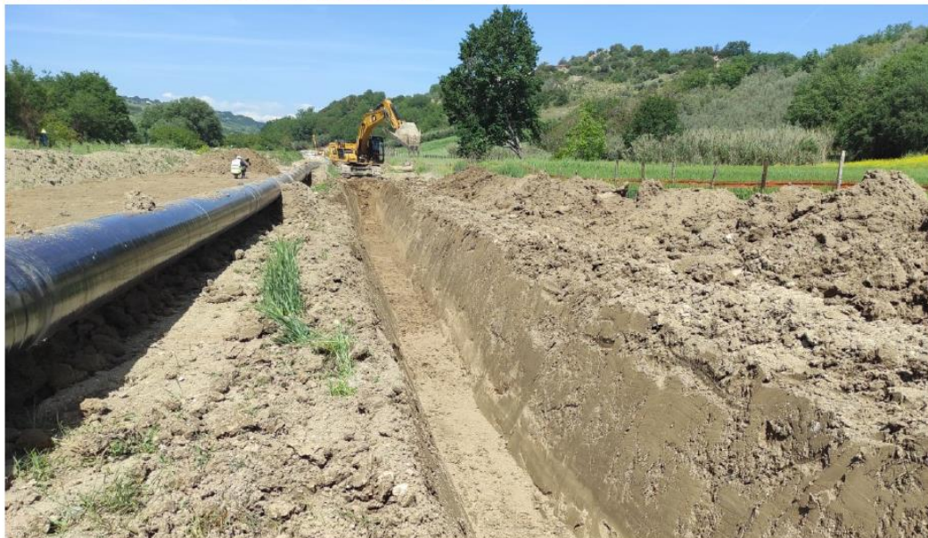
Figura 2-2 - Scavo della trincea – separazione tra terreno scavato (a destra) e l’humus precedentemente accantonato (a sinistra)
