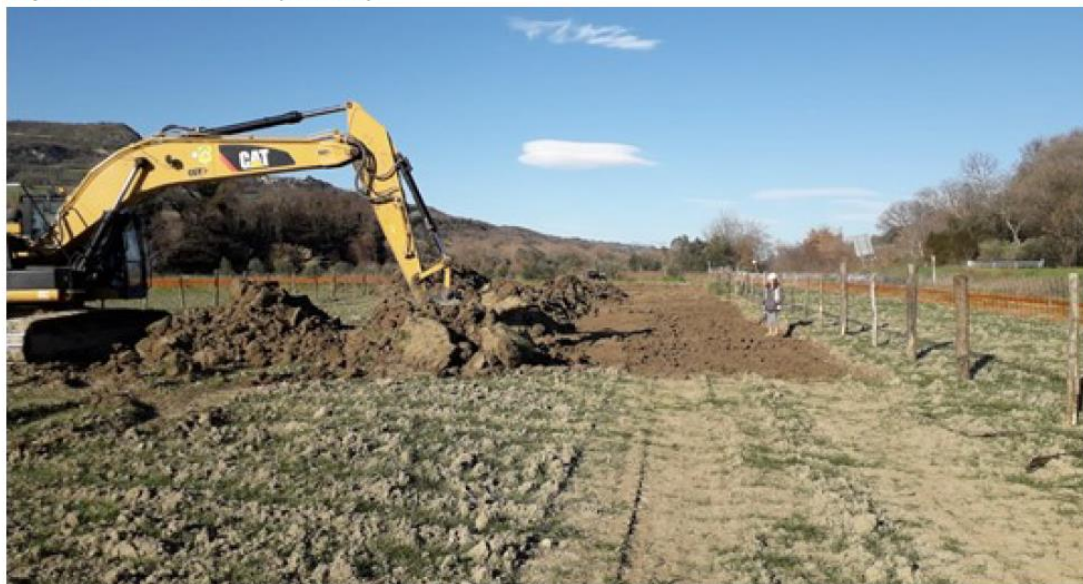
Figura 2-1 - Apertura pista di lavoro con accantonamento (a sinistra) dello strato superficiale di terreno (humus)
