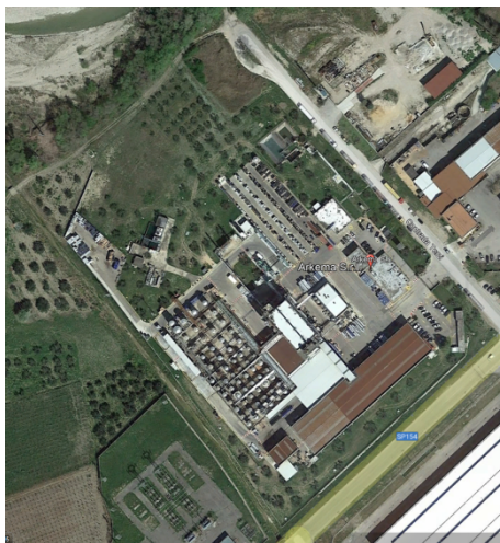
FOTO 1 – ubicazione impianto Arkema S.r.l. – Stabilimento di Gissi (CH)
