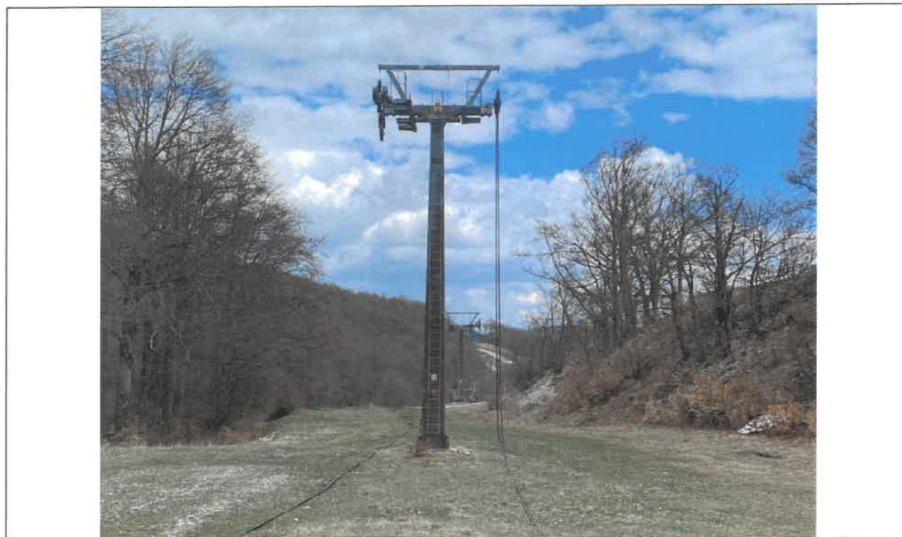
Foto 8 smontaggio fune portante traente su seggiovia triposto
