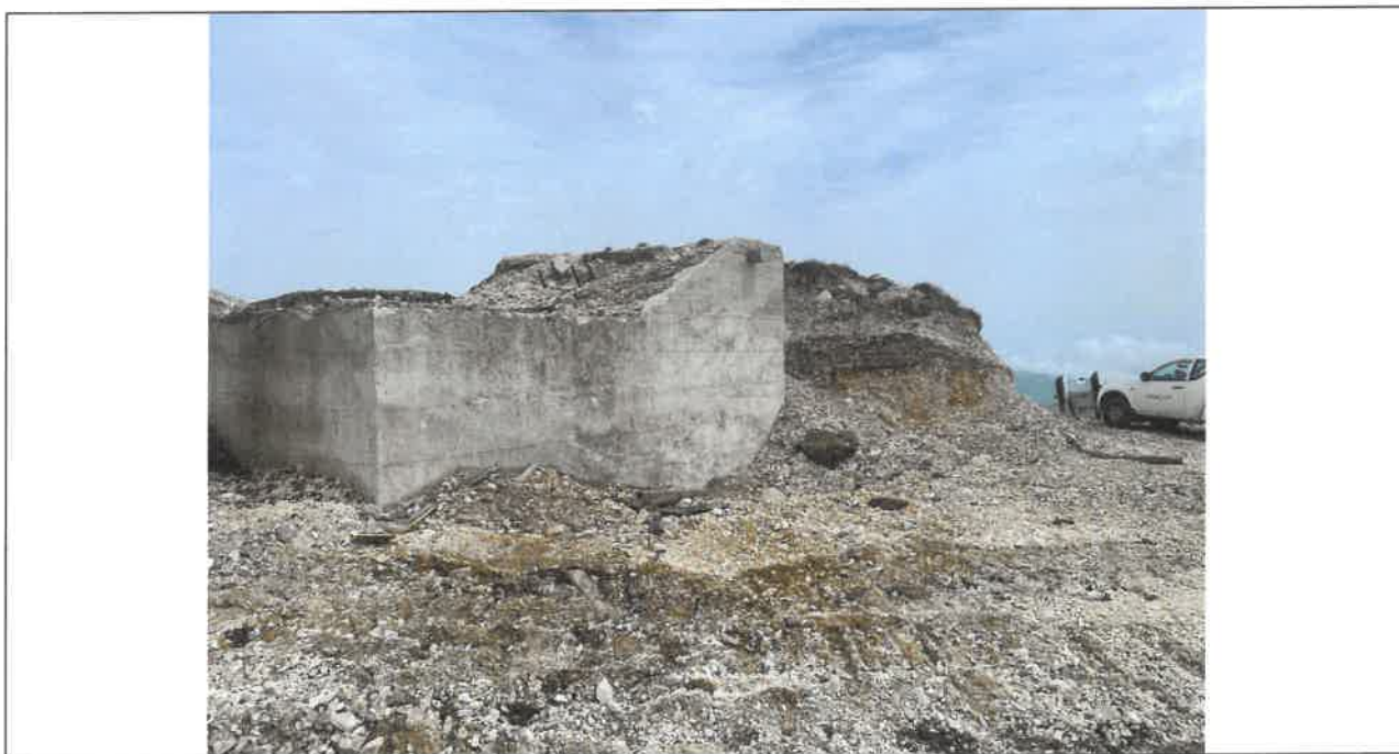
Foto 13 Manufatto di fondazione da demolire con relativi tirafondi (stazione rinvio seggiovia)
