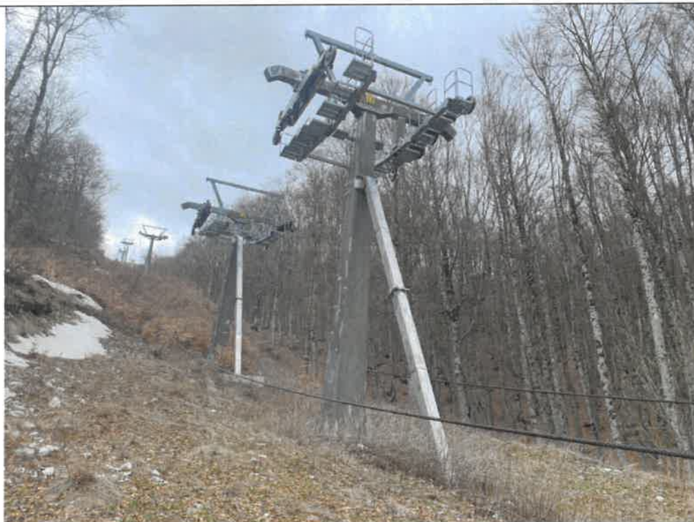
Foto 7 smontaggio fune portante traente su seggiovia triposto
