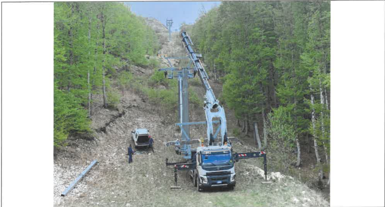
Foto 9 Smontaggio delle testate dei sostegni di una seggiovia
