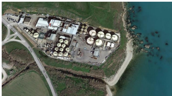
FOTO 1 – ubicazione impianto Eco Fox S.r.l. – Stabilimento di Vasto (CH)
