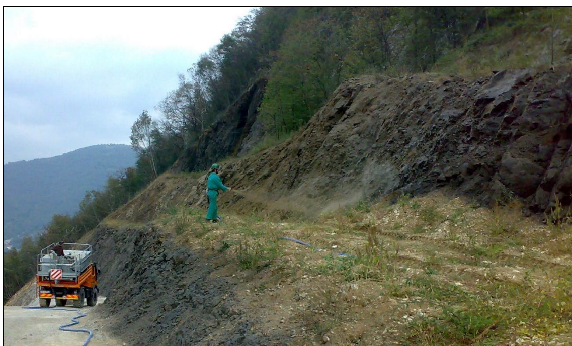
Figg. 7-8-9: fasi dell'idrosemina: preparazione della soluzione, miscelazione e aspersione.
