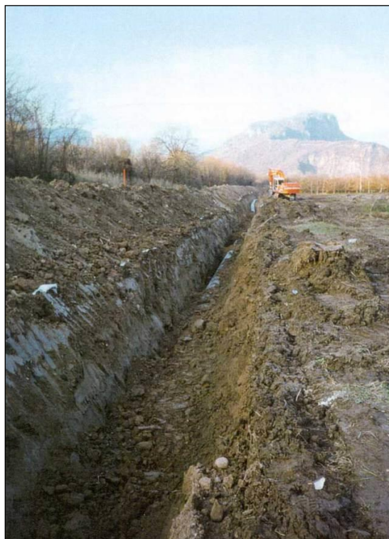
Fig. 8-5 - Operazione di rinterro della condotta
