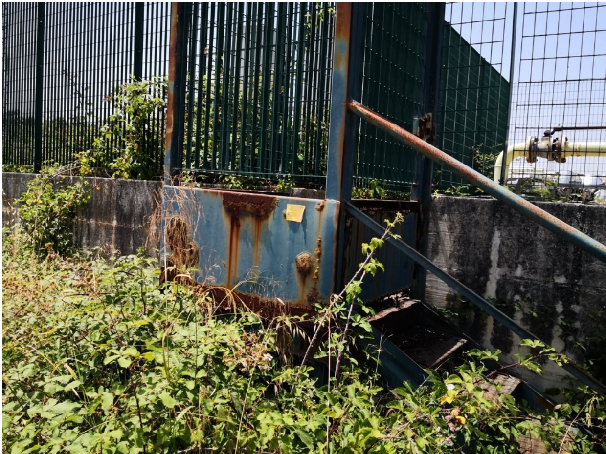
Foto 11: Area di lavoro in cui saranno effettuati i collegamenti elettrici relativi al giunto isolante.
