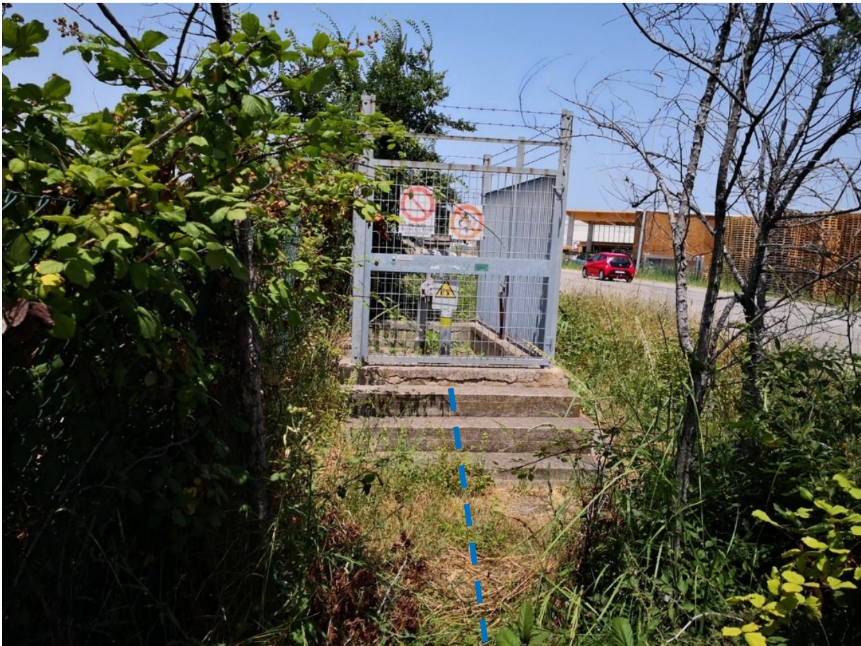
Foto 5: P.I.D.A. n. 4160466/1 da rimuovere
