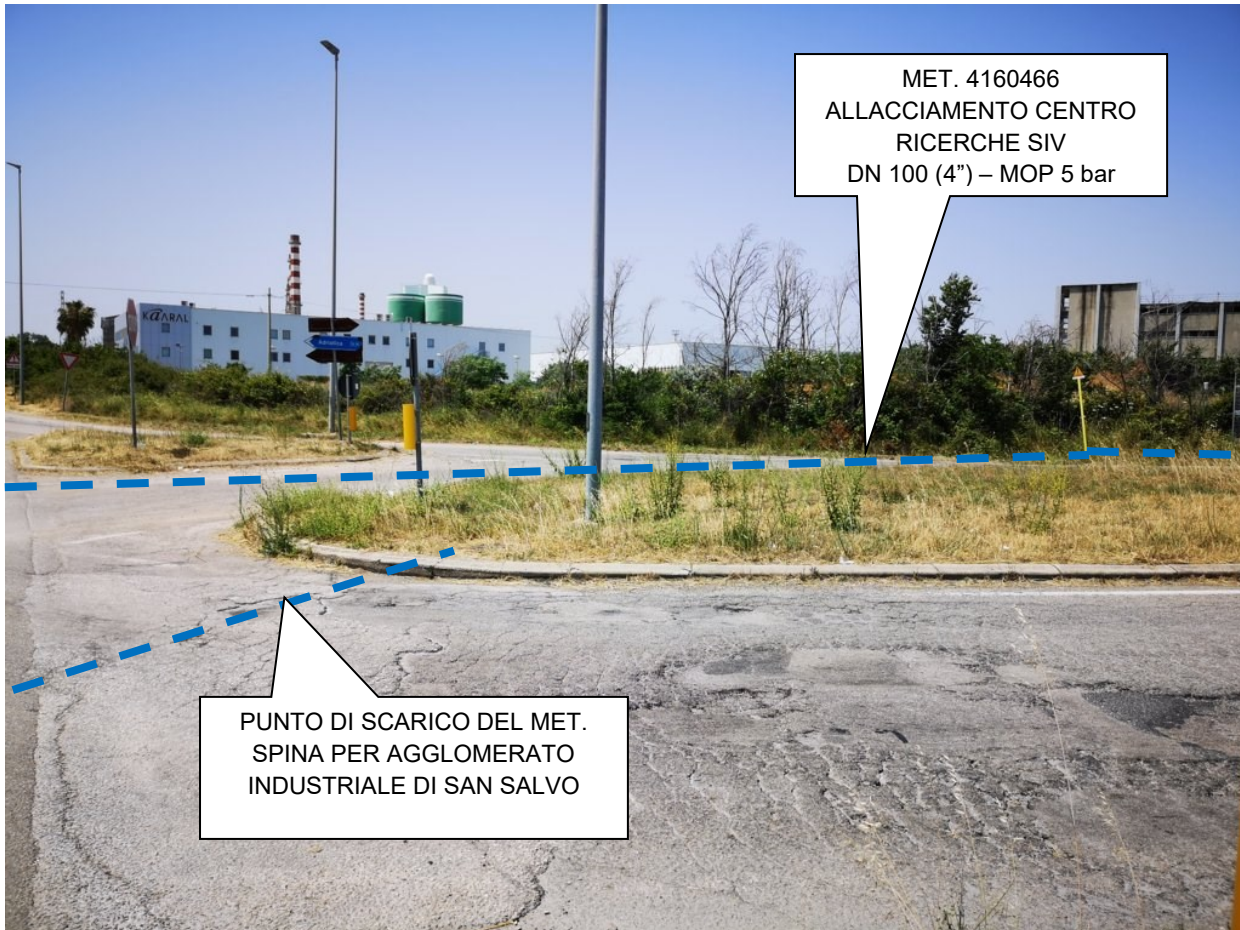
Foto 2: S.P. Trignina - Contrada Piane Sant'Angelo Isola spartitraffico in cui è collocato il punto di scarico isolato da rimuovere e sullo sfondo il Met. 4160466 "Allacciamento Centro Ricerche SIV" DN 100 (4") - 5 bar - in esercizio
