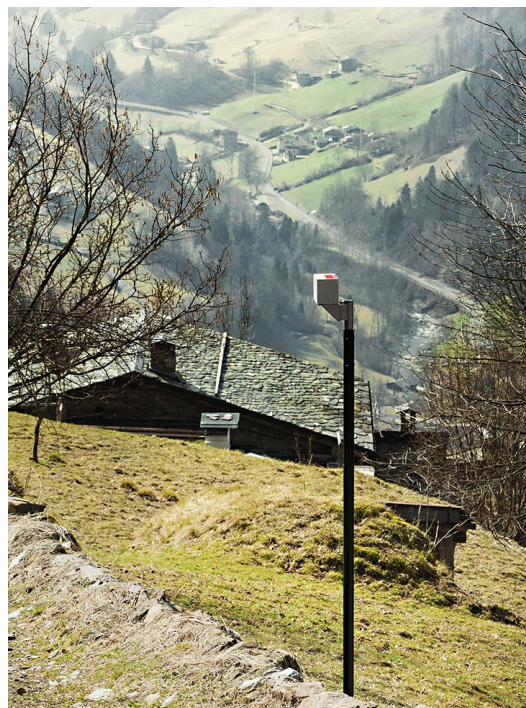
Figura 35 Sistema di monitoraggio di aree in frana
