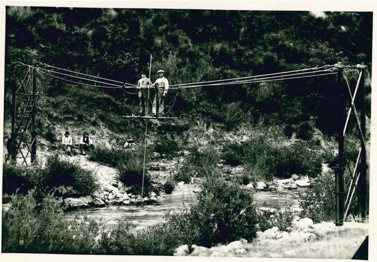
Figura 70 Biferno a Colle D'Anchise (Campobasso), misure di portata
