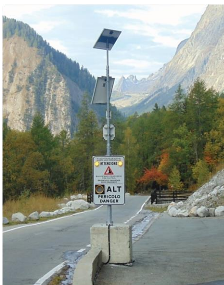
Figura 39 Centralina del sistema ALMOND-F nei pressi del T. Rochefort in Val Ferret
