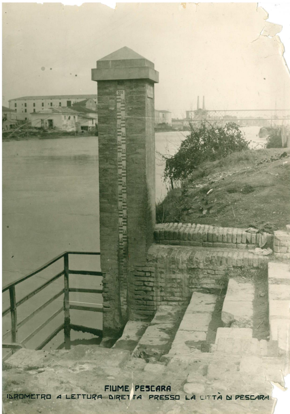
Figura 67: Fiume Pescara, idrometro a lettura presso la città di Pescara
