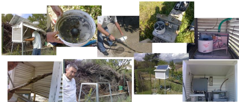
Figura 18 Attività di manutenzione ordinaria di capannine meteorologiche
