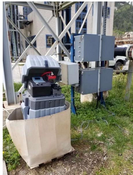
FOTO 8 FOTO 9: CORRENTE 6 E PARTICOLARE AUTOCAMPIONATORE INSTALLATO
