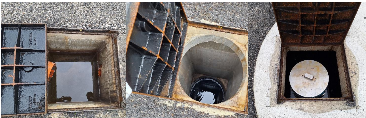
FIGURA 2, FIGURA 3, FIGURA 4: PARTICOLARI DEL POZZETTO PCA1 E DEL DISOLEATORE ASSERVITO ALL'IMPIANTO DI TRATTAMENTO ACQUE DI PRIMA PIOGGIA.
