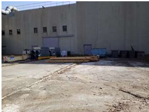
Foto 6: deposito temporaneo area area 5,6
