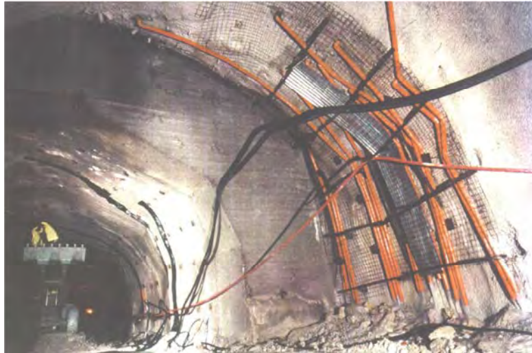
Fig.3 – Opere di drenaggio dell'acqua di roccia
