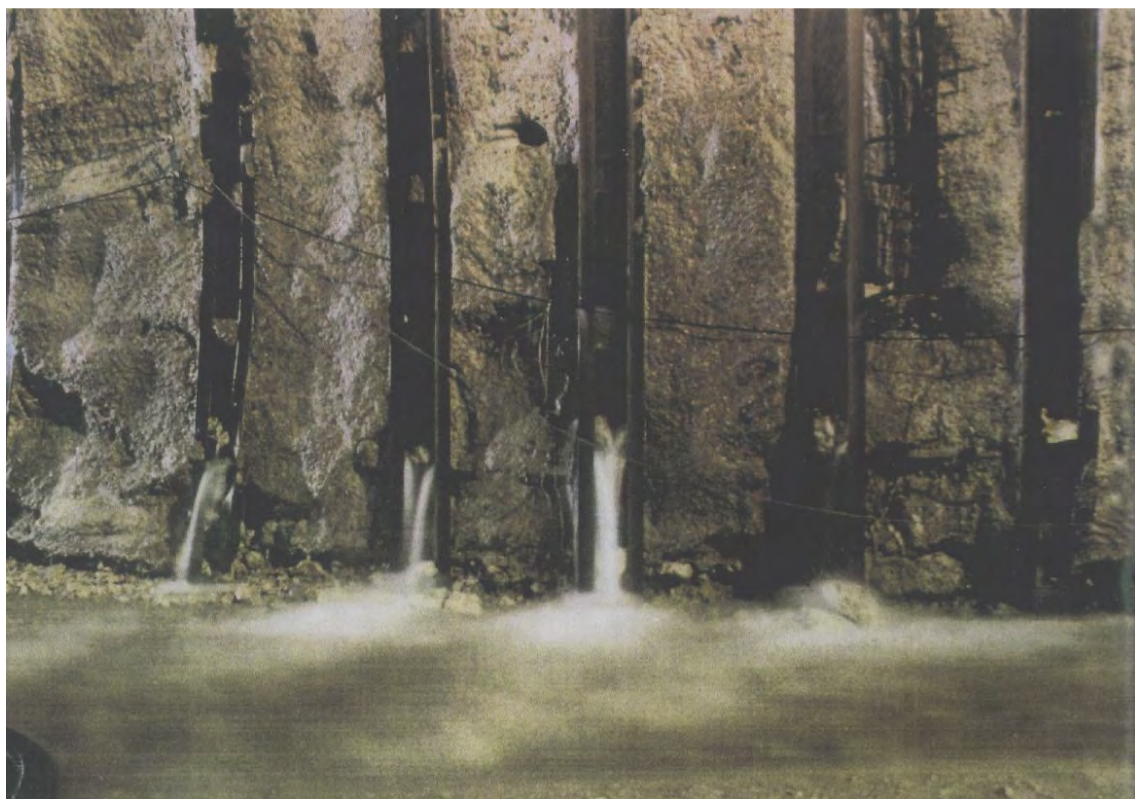
Figura 7- Drenaggio tra centine accoppiate
