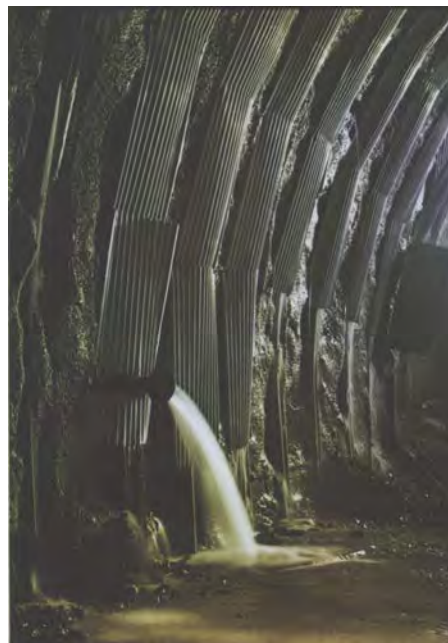
Figura 5 – Elementi di lamiera zincata fissati a centine accoppiate
