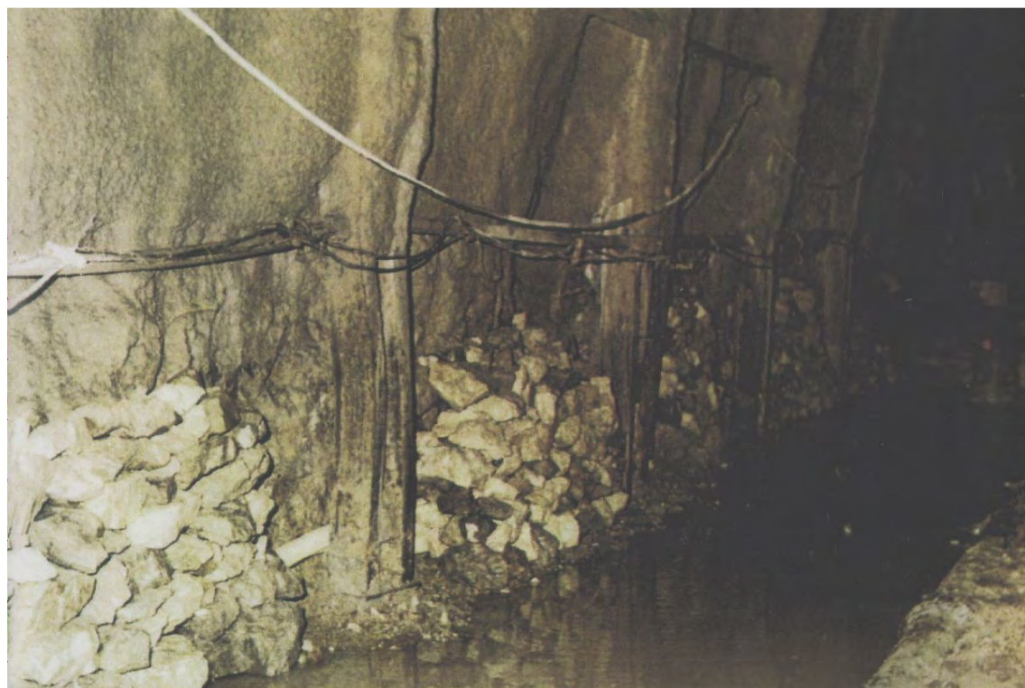
Figura 8 – Drenaggio a tergo delle murette per la raccolta delle acque parietali
