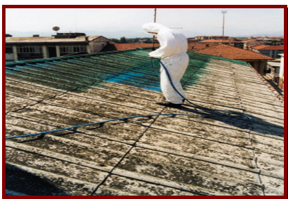
Tetto in lastre grecate
