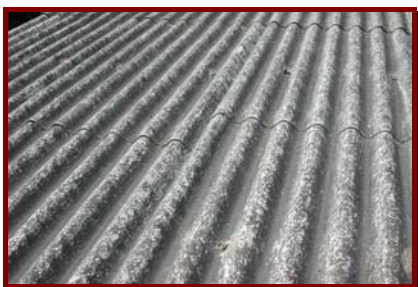
Copertura in cemento-amianto
