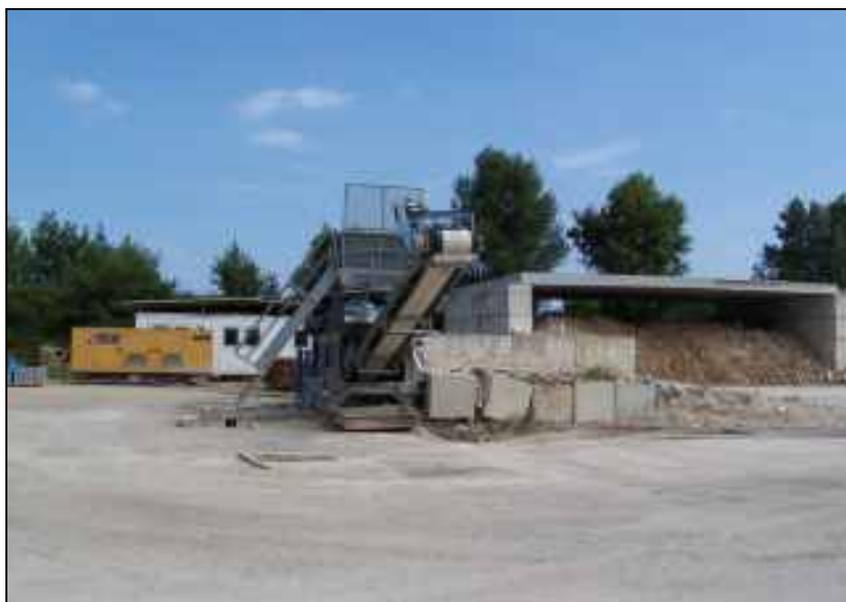
**Fig. 1** - Impianto di recupero inerti con annessa area coperta per messa in riserva
