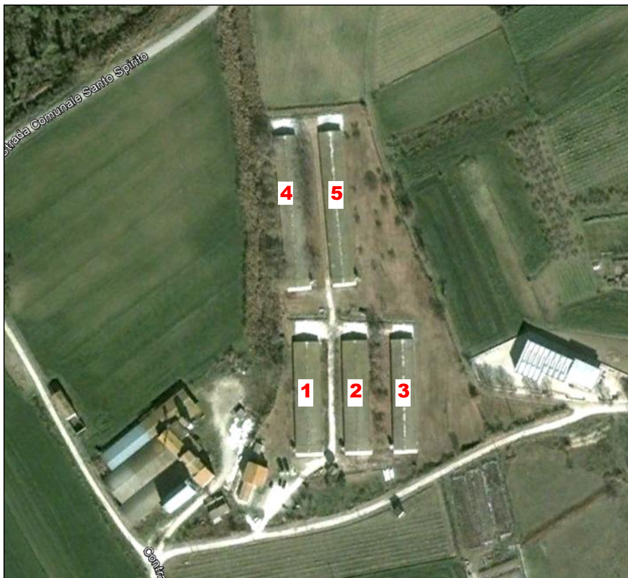
Ortofoto con indicazione dei fabbricati di allevamento (1-2-3-4-5 sono i capannoni)
