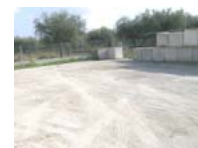
FOTO 4 – VISTA PAVIMENTAZIONE CLS
