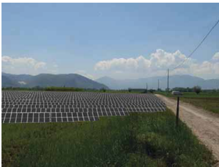
Figura 4: Vista del sito ante e post operam
