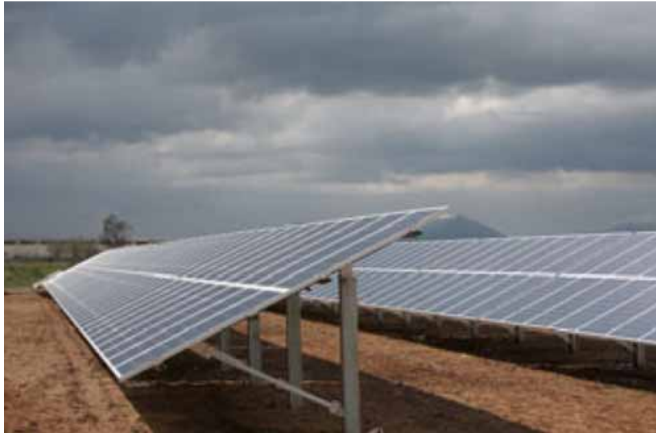
Figura 1: particolare struttura di sostegno
